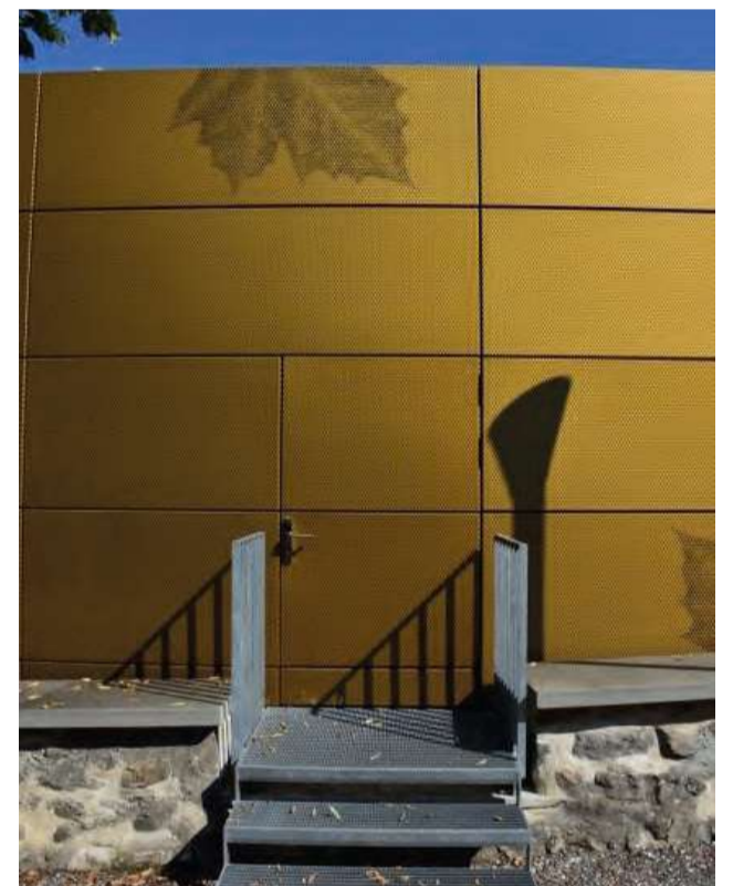
Auch die Fluchweg-Türe wurde sehr geschickt in die Fassade integriert.
